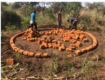
Het begin van bouw van drie hutten op het terrein.
